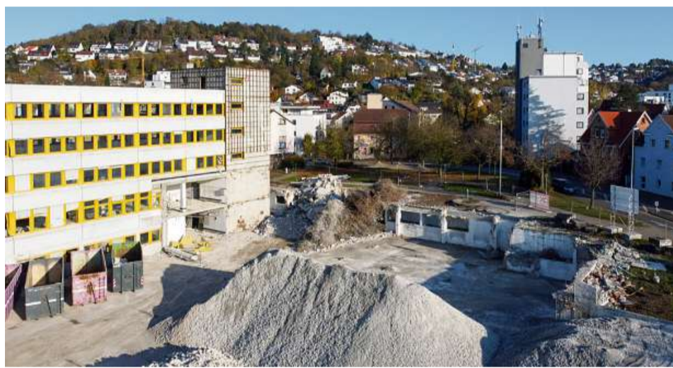
Baustelle Postareal: Für die FDP ein positives Signal in der Stadtentwicklung.
